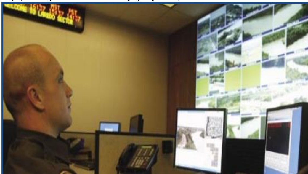
Рисунок 5. – Рабочее место оператора стационарного поста мониторинга обстановки
