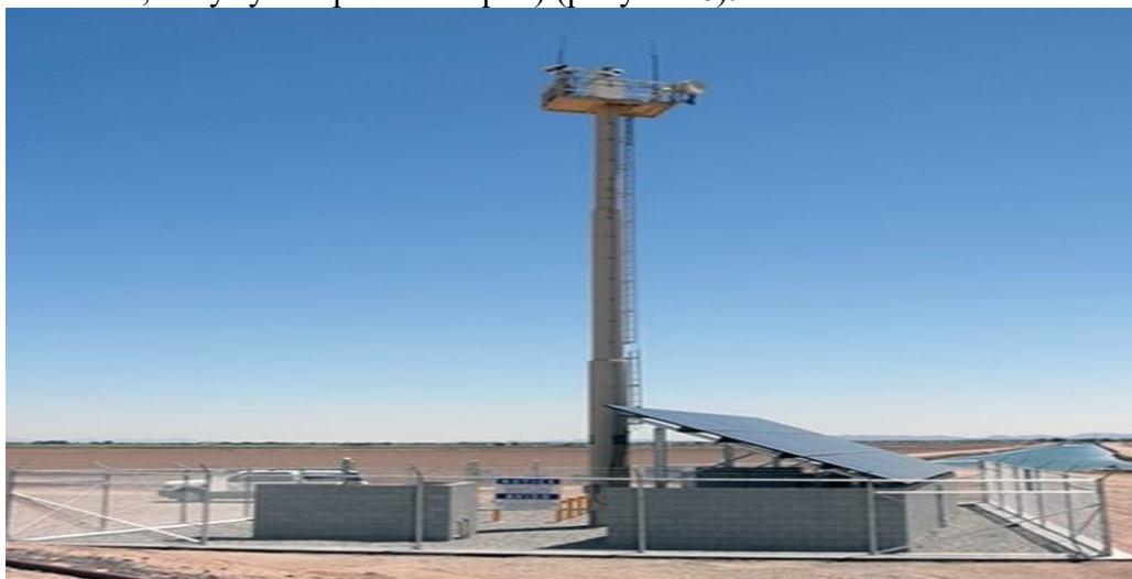
Рисунок 6. – Автономная пограничная наблюдательная вышка на южной границе США
